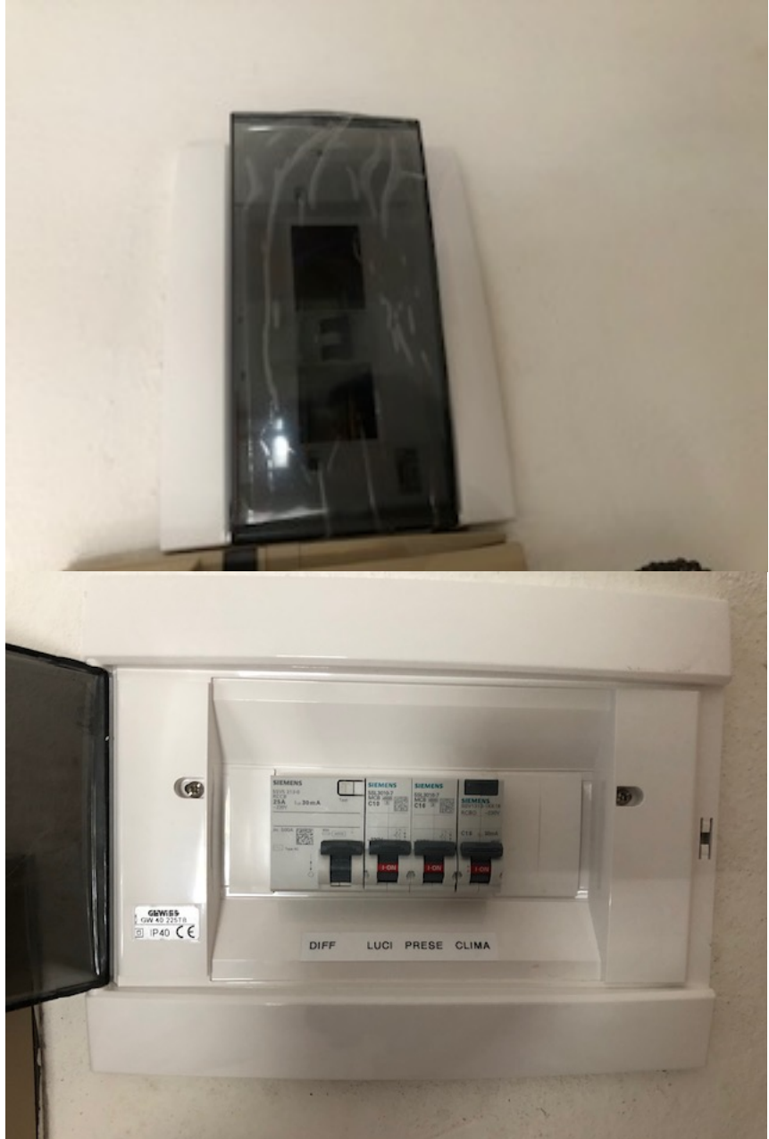
Nuova protezione in appartamento
