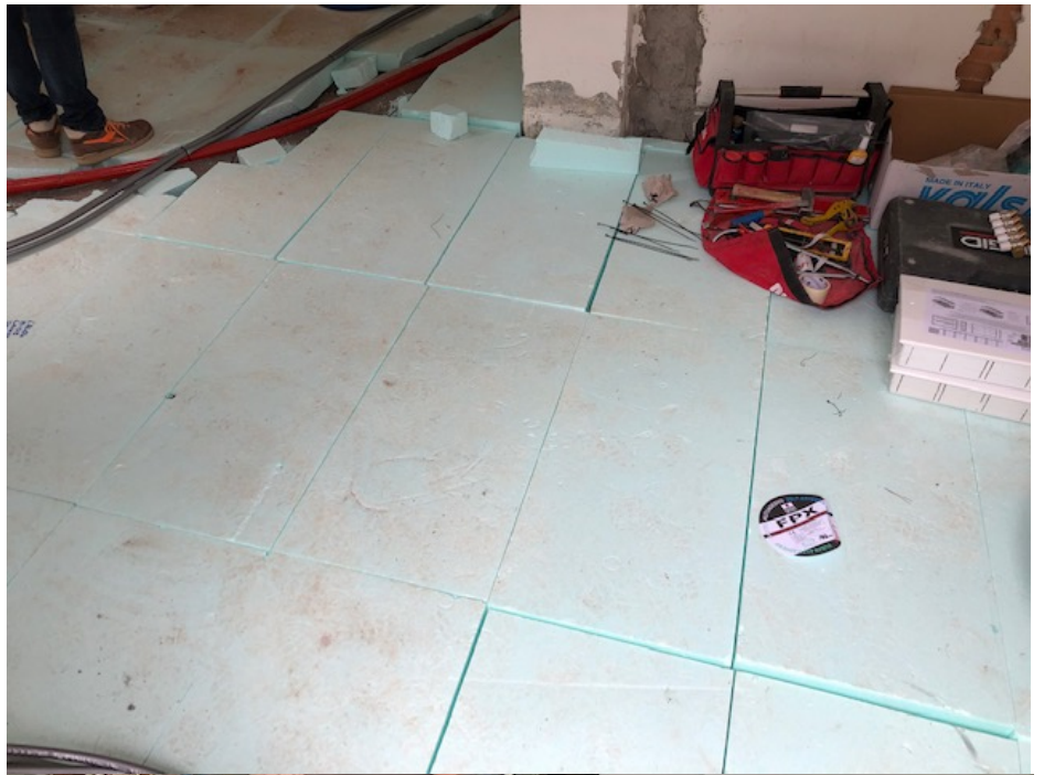
Isolamento termico piani terra
