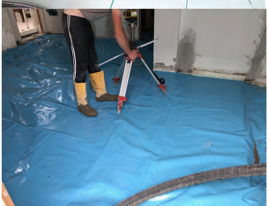
Preparazione posa massetto
